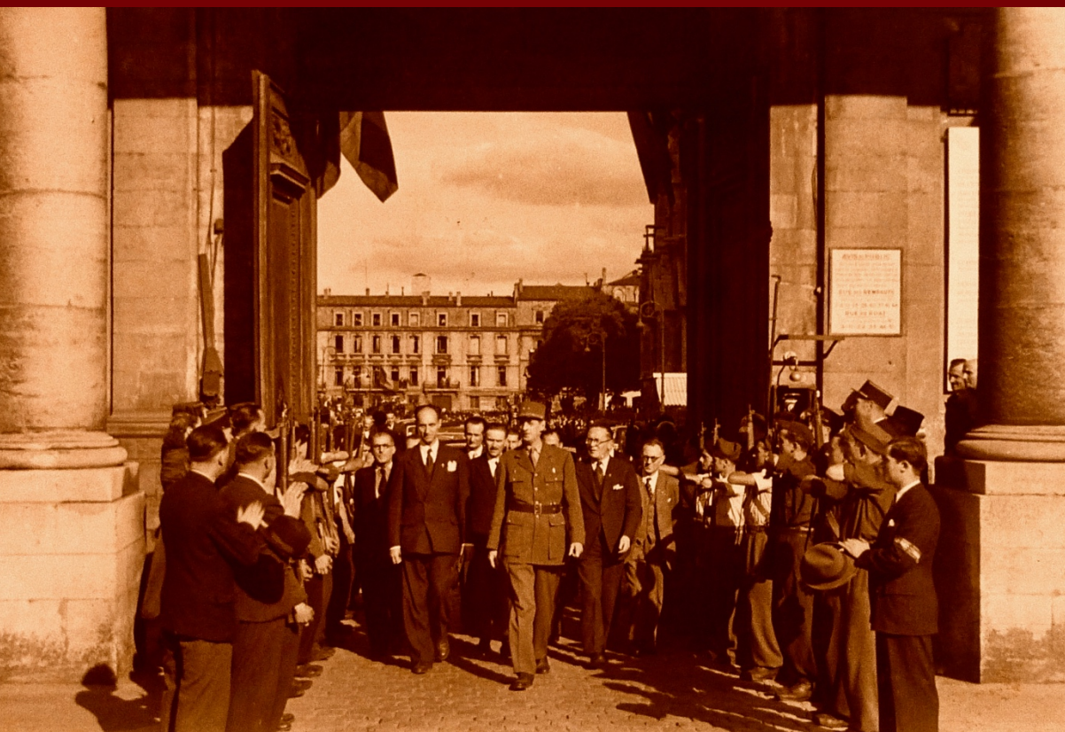
Arrivée du Général de Gaulle et du Commissaire de la République Gaston Cusin dans la Cour de la Mairie de Bordeaux (17 septembre 1944)
